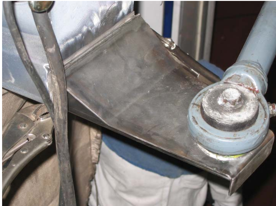
Umbau an einer Straßenbahn – Fugenvorbereitung. Foto: Parschan 2008
