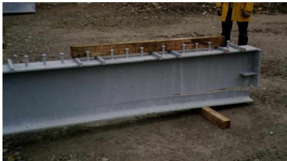
Verbundträger für ein Parkhaus in Mainz
