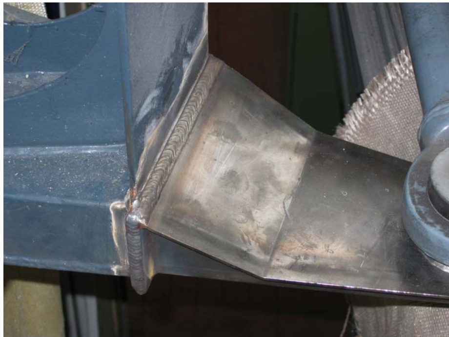
Umbau an einer Straßenbahn – fertiggestellte Naht. Foto: Knödel 2008
