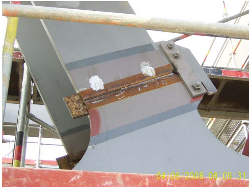
Eisenbahnbrücke über die A8 bei der Ausfahrt Burgau im Bauzustand
