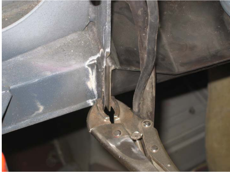
Umbau an einer Straßenbahn – Fugenvorbereitung. Foto: Parschan 2008
