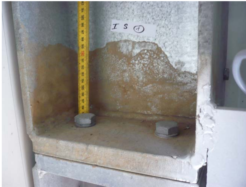
Anonymisiertes Beispiel für nicht verzinkungsgerechtes Konstruieren. Foto: Helleis 2009
