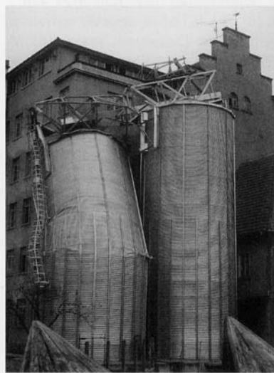
Bild 6. Durch Fehlbedienung (ungleichmäßige Silolast) umgekippter Wellblech-silo Fig. 6. Silo tilted because of wrong operation (nonuniform silo load)
