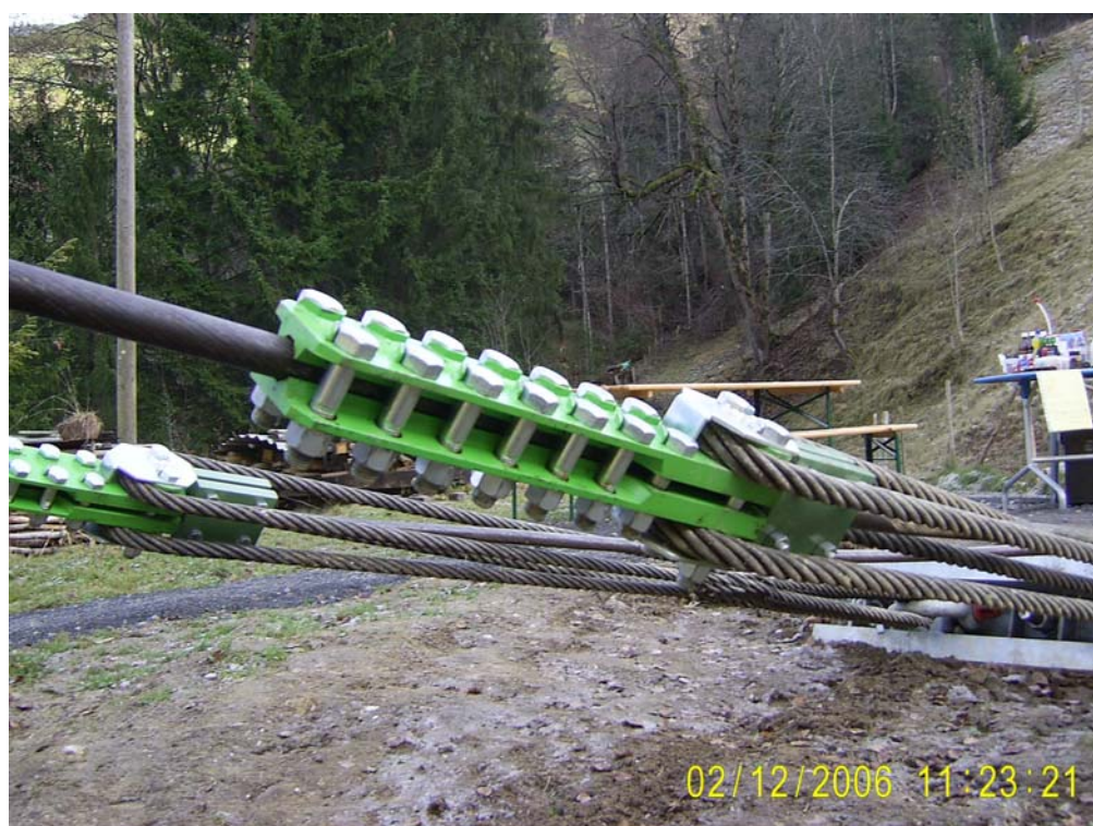
Anschluss der Tragseile an das Widerlager (Foto: Peter Knödel 2006)
