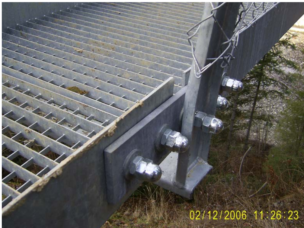
Anschluss Fahrbahn an Hänger (Foto: Peter Knödel 2006)
