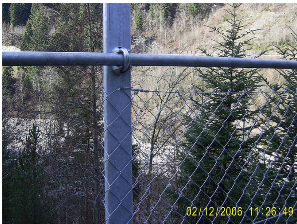
Anschluss Handlauf und Geländerfüllung (Foto: Peter Knödel 2006)
